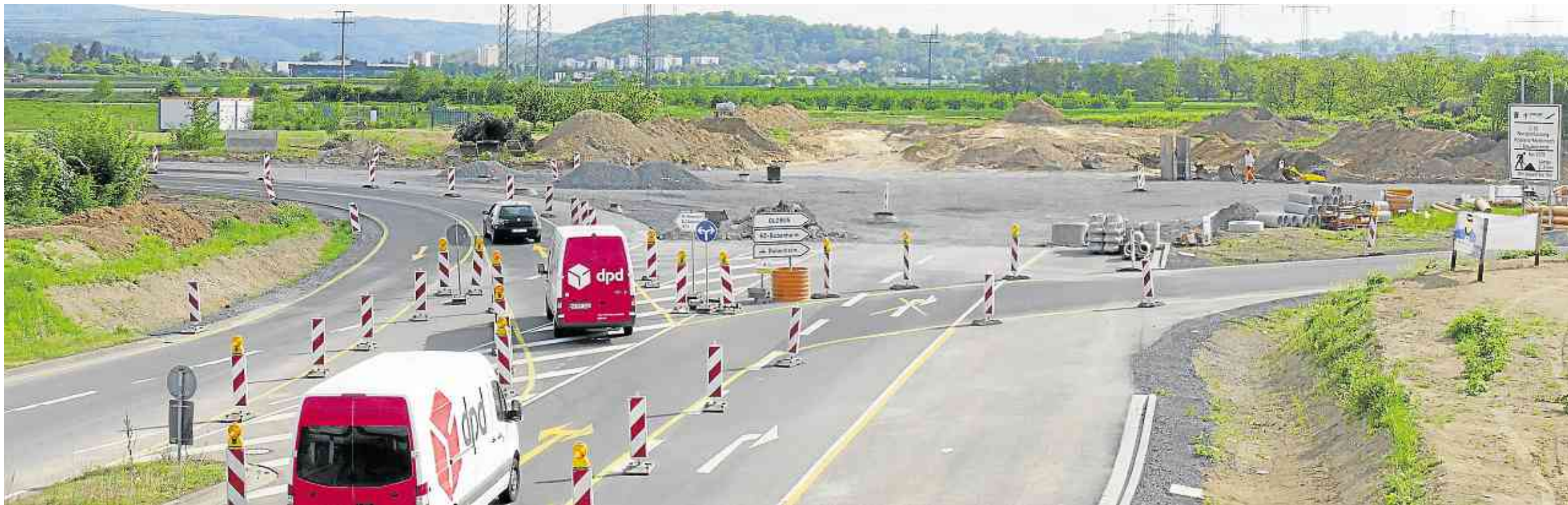
Dass zumindest die kleine Lösung für die Nordtangente nicht mehr aufzuhalten ist, zeigt sich derzeit am ehemaligen Ikea-Kreisel, der in eine Kreuzung mit Lichtsignalanlagen umgebaut wird.
